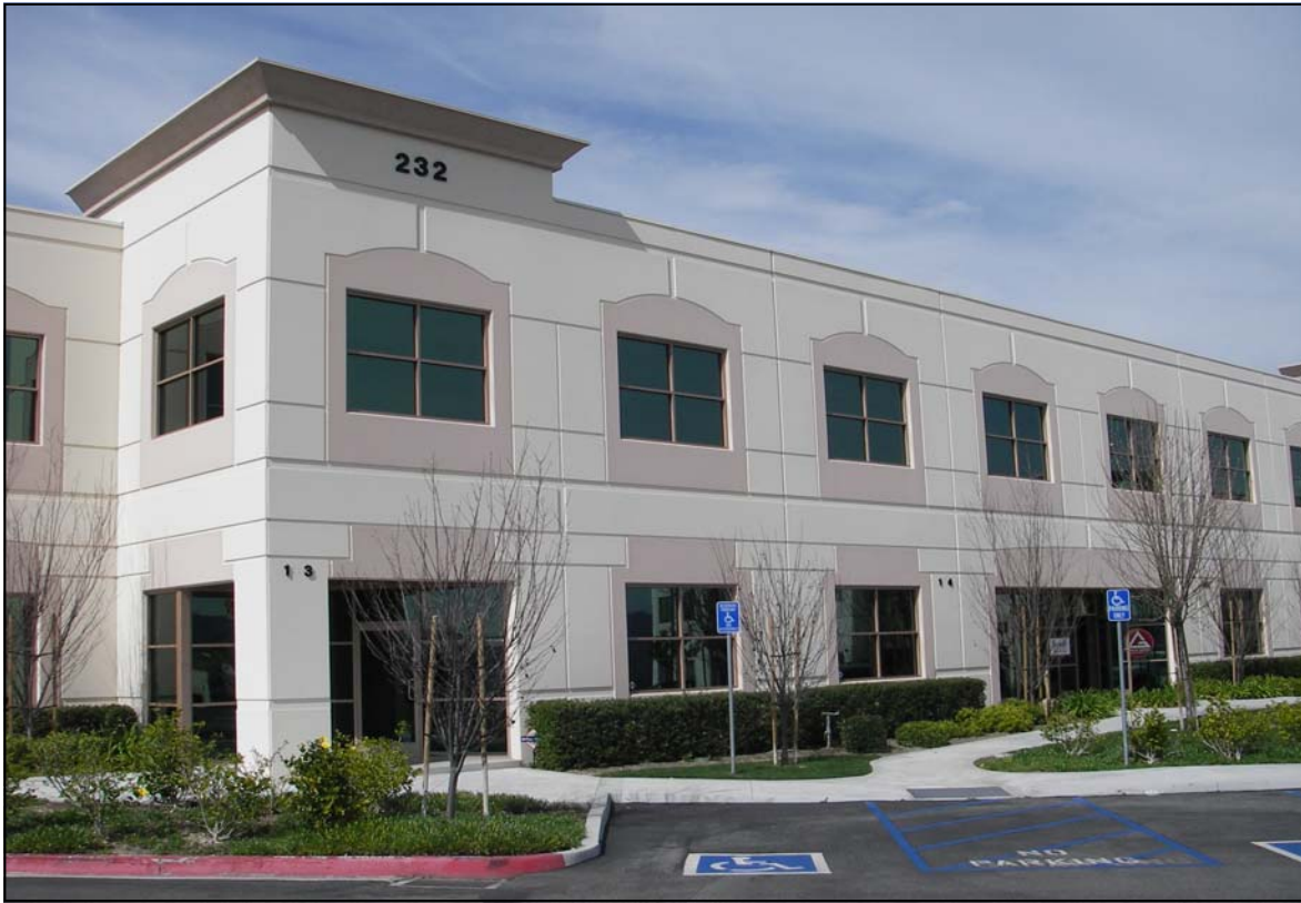
232 Avenida Fabricante #103 & #104, San Clemente
